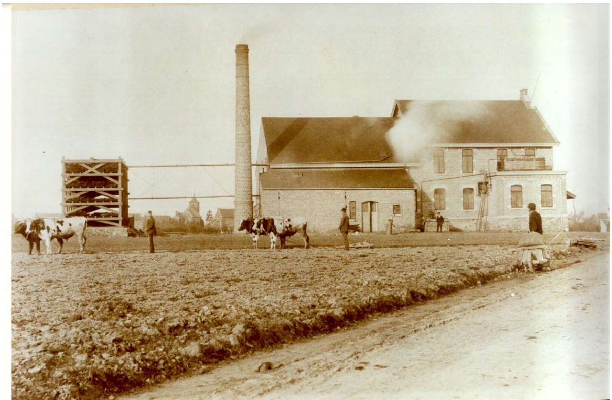
La laiterie vue de la route de Burdinne. A l'extrême gauche, le refroidisseur d'eau (+/- 1905)
