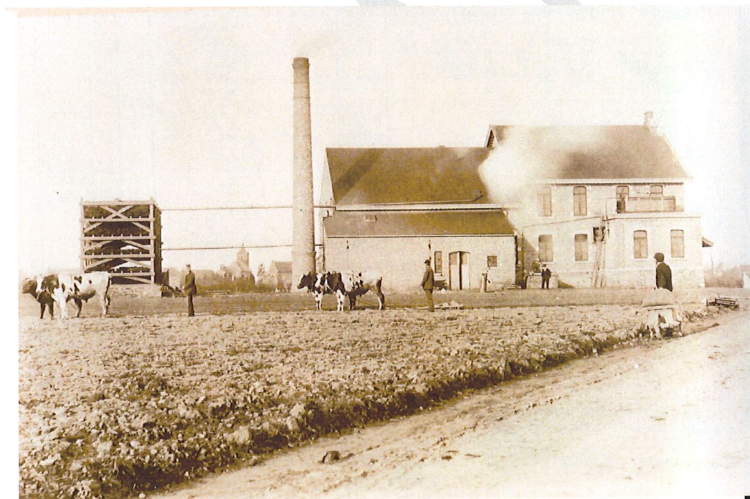
La laiterie vue de la route de Burdinne. A l'extrême gauche, le refroidisseur d'eau (+/- 1905)
